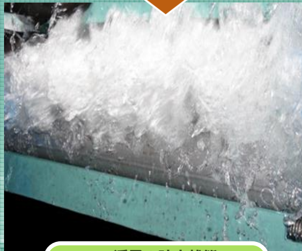
➤ 浮子の吐水状態
